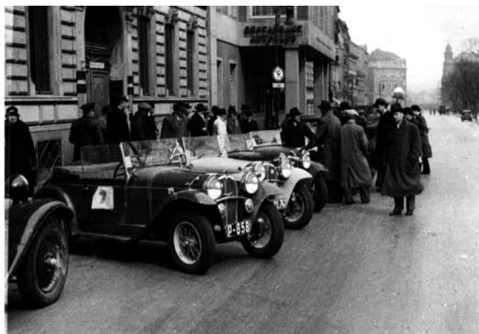
Po příjezdu před autoklubem
